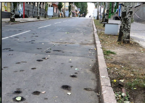
Les sillons des caffûts près de l'immeuble d'habitation
